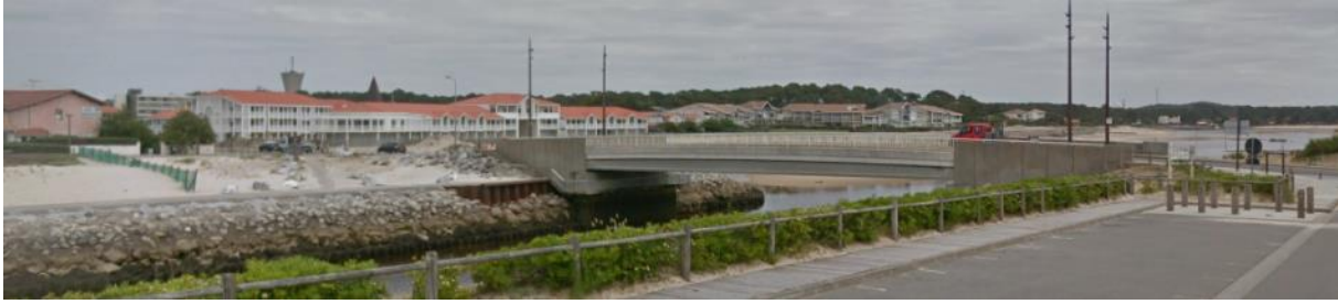
Figure 16 : Pont du courant et début des perrés
